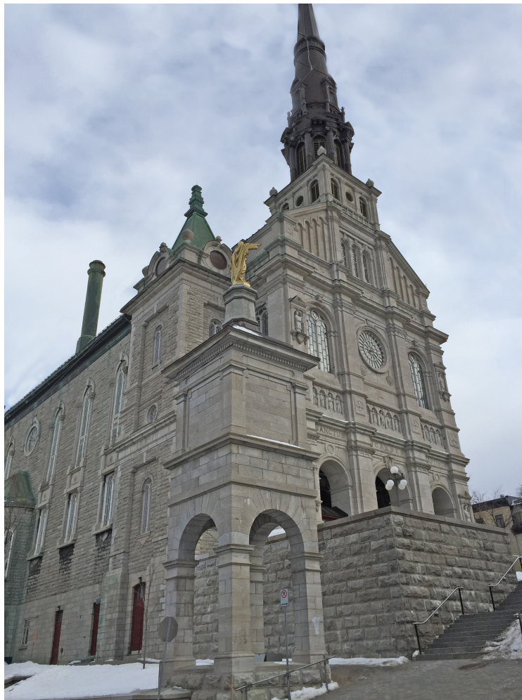
Figure 11 : Façade de l'église vue depuis la rue d'Aiguillon
