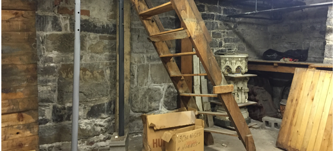
Figure 6: Mur de fondation encore existant depuis la construction de la première église
