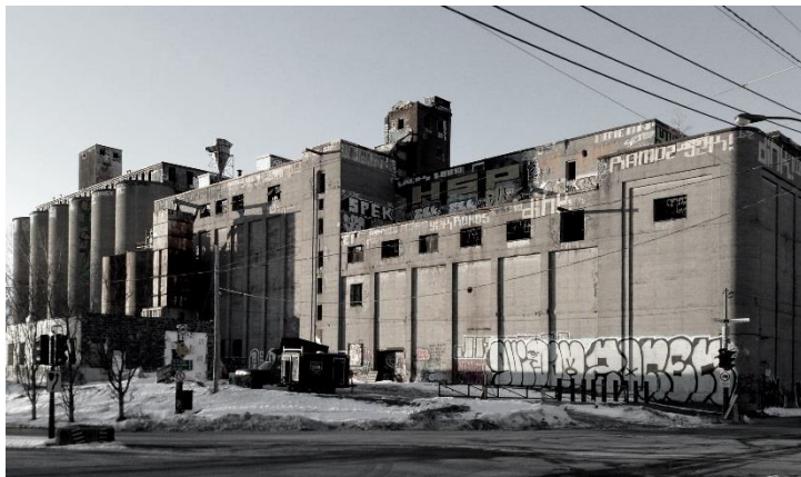
Figure 1.5.2 Malterie datant de 1950. Photographie de l'auteur, 2016.
