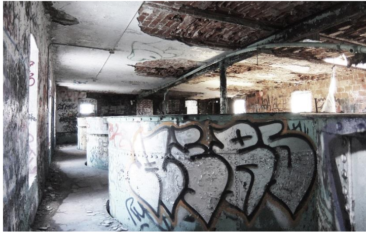
Figure 1.5.5 Cuves de trempage - malterie 1905. Photographie de l'auteur, 2016.
