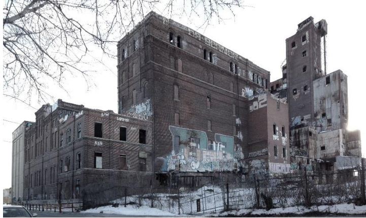
Figure 1.5.1 Malterie datant de 1905. Photographie de l'auteur, 2016.
