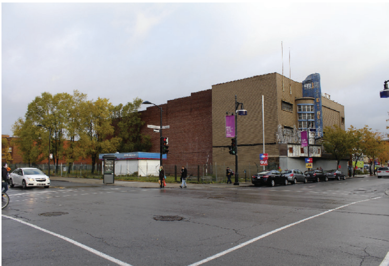
Figure 15 - Photo du site depuis l'intersection Papineau / Sainte-Catherine Est
