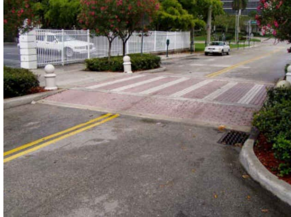
Figure 26 — Exemple de traverse piétonne surélevée
