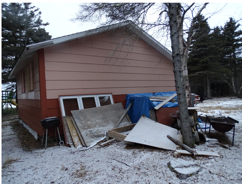
Figure 37 : Entreposage de matériaux à l'arrière du bâti
