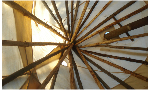
Figure 18 : Structure apparente à l'intérieur d'un tipi
