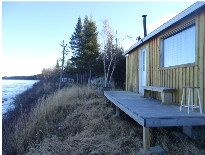
Figure 51 : « Entre-deux » des chalets, Shipit
