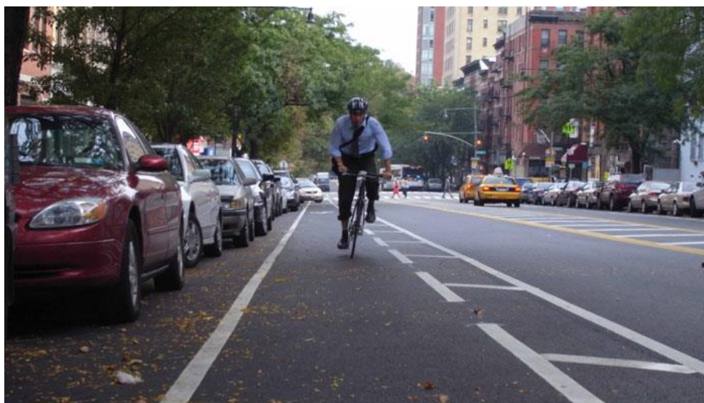
Figure 32 Bande tampon séparant la bande cyclable de la voie (tirée de NACTO, 2014)
