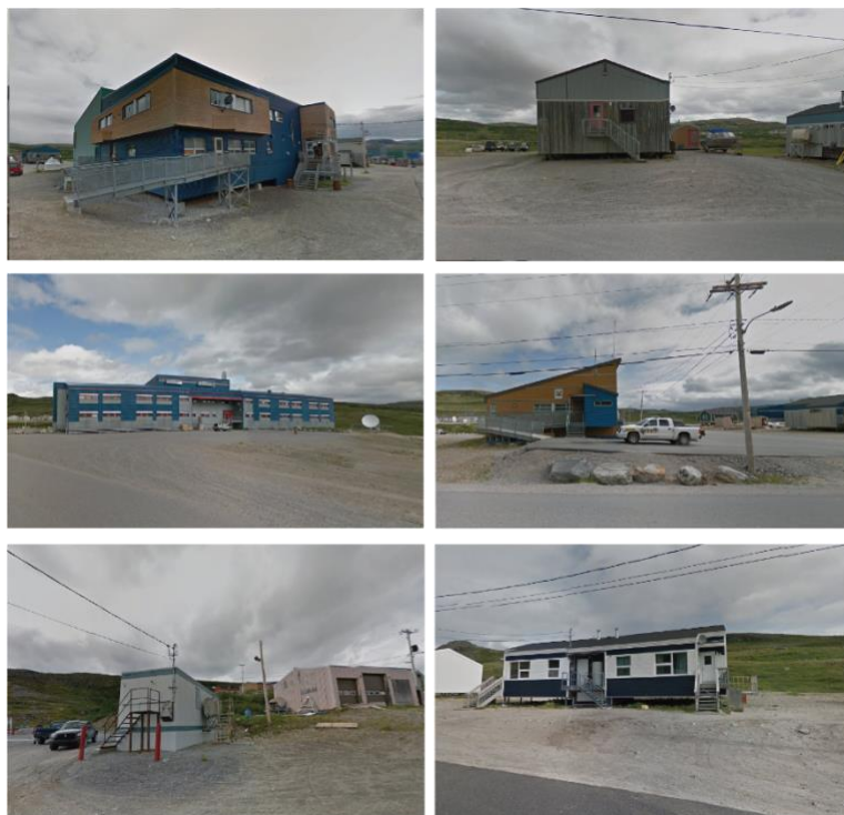
Figure 26. Images de bâtiments situés à Kangiqsualujuaq, récupérées sur Google Street View (source : Google Street View 2024)
