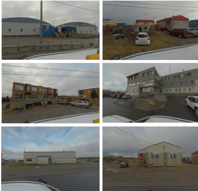
Figure 25. Images de bâtiments situés à Kunijuaq, récupérées sur Google Street View (source : Google Street View 2024)
