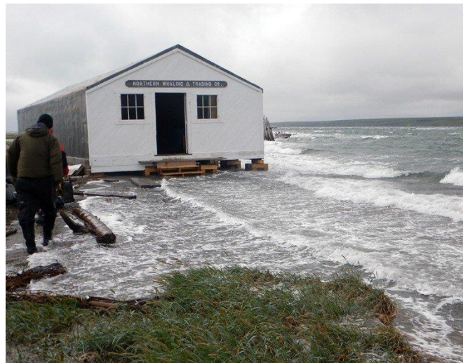
Figure 11. Infrastructure historique pour la chasse à la baleine faisant face à un à risque d'inondation, bien que ses fondations aient été surélevées, Île Herschel, Yukon. Photo du Gouvernement du Yukon, s.d.
