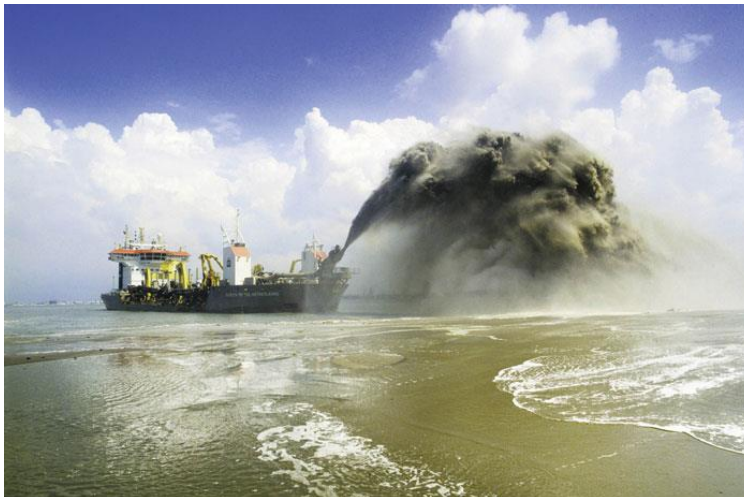
Figure 23. Rechargement des plages ( Beach Nourishment ), Dutch Coast, Pays-Bas, 2009. Photo de Royal Boskalis Westminster NV
