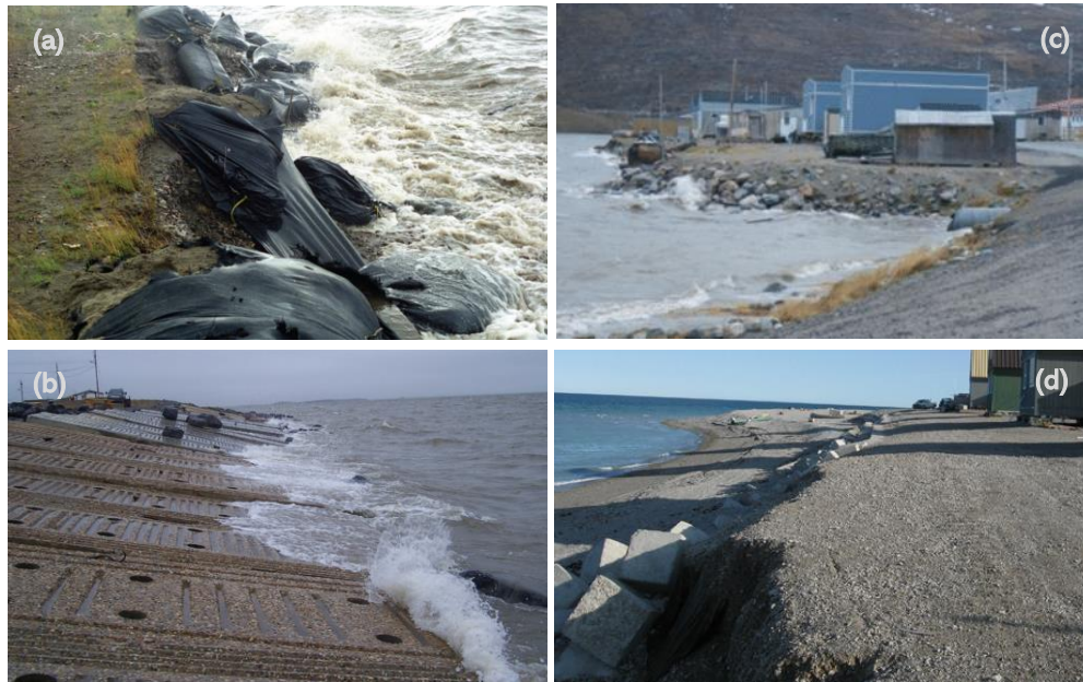
Figure 3. Diverses mesures de protection du littoral le long de la côte nordique canadienne : (a) Sacs de sable mis en place en 1987, Tuktoyaktuk, Territoires du Nord-Ouest (Lemmen 2016). (b) Dalles de béton monolithiques installées en 1998, Tuktoyaktuk, Territoires du Nord-Ouest (Lemmen 2016). (c) Enrochement artificiel, Salluit, Nunavik (Ropars 2010). (d) Protection faite d'éléments en béton, Sanirajak, Nunavut (Northern images, Hall Beach, Nunavut)
