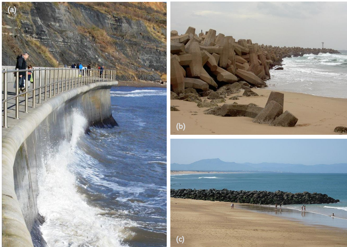
Figure 20. Mesures de protection du littoral déployées par une ingénierie dure : (a) Digue courbe, Lyme Regis, Angleterre (Cobb Sea Wall tiré de chandlercottage.co.uk ). (b) Éléments de brise-lames en béton du style Dolos, Durban, Afrique du Sud. Photo de Henry Trotter, 2006. (c) Épi en enrochement, Landes, France. Photo libre de droits, 2009
