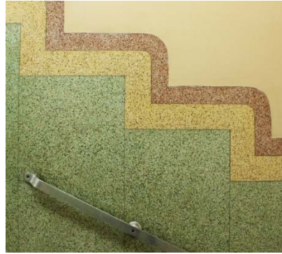
Figure 25 : Détails du terrazzo dans l'escalier d'entrée. Source : par l'auteure
