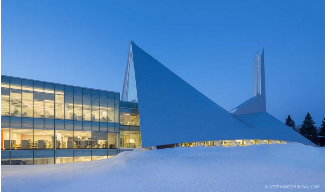
Figure 3 : Bibliothèque Monique-Corriveau. Source : Côté Leahy Cardas architectes. [En ligne]. clcarchitectes.com (Page consultée le 22 novembre 2014)
