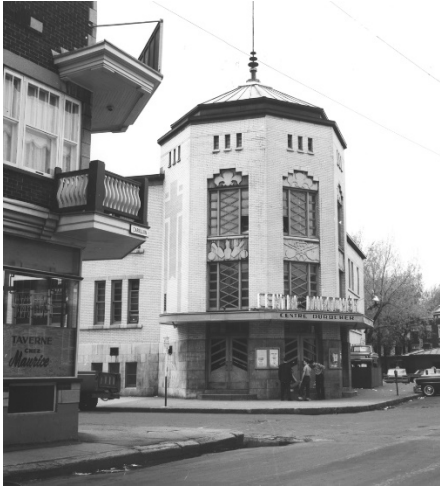
Figure 21 : La tour dans les années 1960. Source : Le centre Durocher, d'hier à aujourd'hui. Nouvelles du quartier. [En ligne]. http://qc.nouvellesduquartier.com/articles/342/1/Le-centre-Durocher-dhier-a-aujourd'hui/Page1.html (Page consultée le 28 avril 2015)
