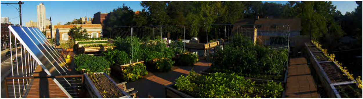
Figure 3 : Toit du Restaurant Uncommon Ground à Chicago
